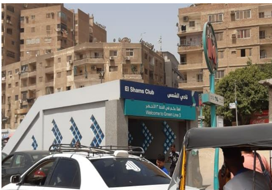
صورة (٦) محطة مترو نادي الشمس (١٤ مارس ٢٠٢٥)
