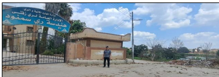
صورة (٩) مبنى هندسة رى سمنود بجوار الضفة الغربية لمجرى فرع دمياط بالمنطقة اتجاه النظر صوب الشمال الشرقي
