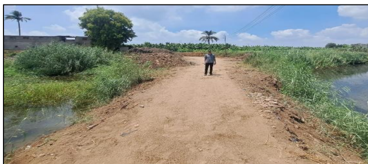
صورة (١٢) السد الترابي بين جزيرة سمند ومنية سمند مما ساعد على تراكم كثير من الرواسب اتجاه النظر صوب الغرب
