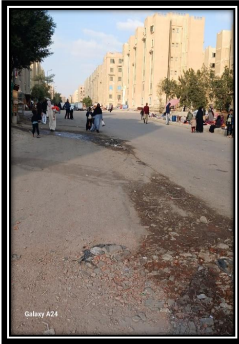
صورة (٢٨) توضح تسريب الصرف بشوارع رئيسي بتاريخ ٢٠/٨/٢٠٢٤.
