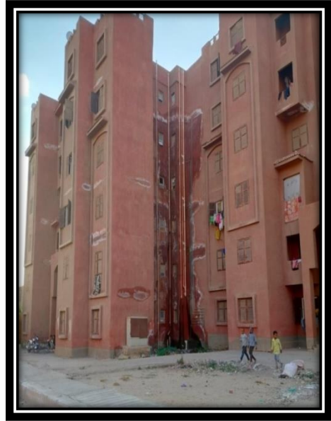
صورة (٢٠) توضح الرطوبة بجدران المباني بتاريخ ٢٠/٨/٢٠٢٤.
