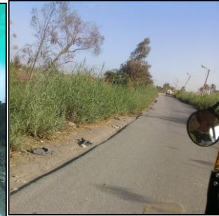
الدراسة الميدانية ٢٠٢٠/٤/٢١ صورة (١٣) ضيق الطرق المرصوفة بالمركز ، طريق شرمساح - كفر تقي
