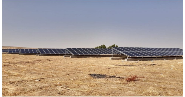
صورة (٧) محطة طاقة شمسية ٦٠ كيلو وات لتشغيل موتور ٦٠ حصان . الموقع أبو تشتت عزبة البوصة بقنا ٢٠١٨/٣/١٧ م.
