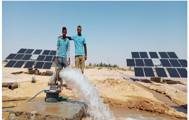
صورة (٩) محطة طاقة شمسية ٢٦ كيلو وات لتشغيل موتور ٣٠ حصان . الموقع الكيلو ١٧ قنا سوهاج ٢٠١٨/٣/١٩ م.
