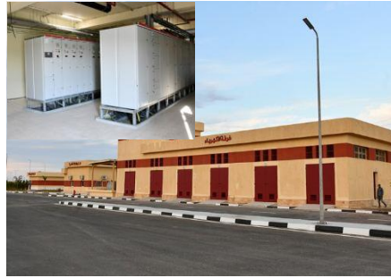
صورة (٩) جاتب من محطة الكهرباء المغذية للأنفاق
